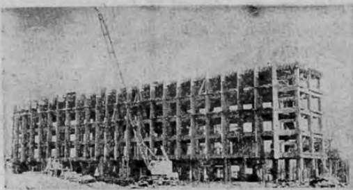
Estructura del Hospital Monseñor Sanabria, que se levanta en la Ciudad de Puntarenas.
