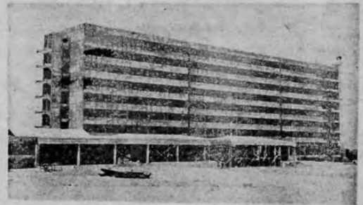
Hospital México, con su edificio de Consulta Externa al frente.
